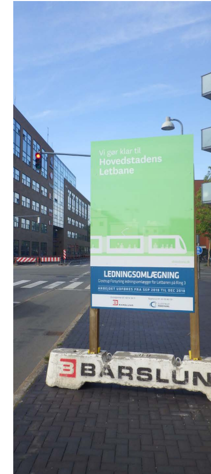
Det var også året, hvor de første ledningsomlægninger gik i gang langs Ring 3. Hovedstadens Letbane har udarbejdet skabeloner til skilte og breve til ledningsejerne. Her ses skilte i Glostrup.
