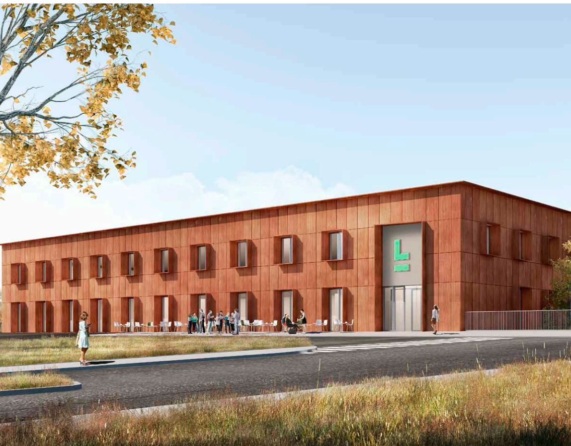
Kontrol- og vedligeholdelsescentret, Glostrup
